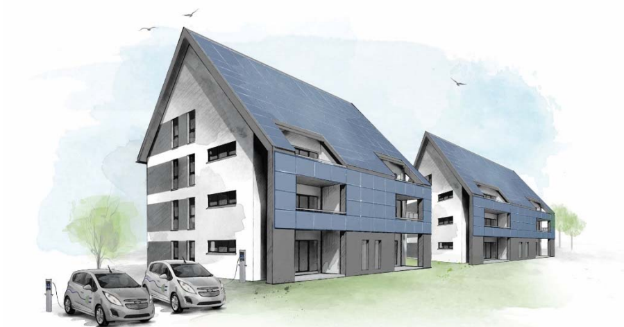
➤ Abb. 9: Miete mit Energieflat: Energieautarkes Mehrfamilienhaus mit 6 Wohneinheiten in Wilhelmshaven, Baubeginn geplant 2017. 96 m 2 Solarthermie mit 19 m 3 Langzeitwärmespeicher sowie 28 KWP Photovoltaik auf dem Dach und an den Balkonen mit 54 kWh Akku erreichen rund 70 % solare Deckung bei Strom und Wärme. Der Vermieter kann dem Mieter für mehrere Jahre eine Pauschalmitte anbieten, in der Wohnen, Wärme, Strom und E-Mobilität als flatrate bereits enthalten ist. Bildquelle: Spar- und Baugesellschaft Wilhelmshaven
