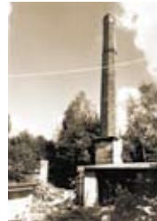
Schornstein der Glühöfen im Walzwerk, provisorische Nachkriegsbebauung
