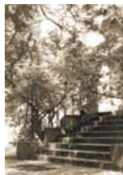
Freitreppe an der Gartenseite der Herrenhausruine
