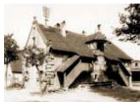
Uhrenhaus, Ansicht von Südosten, im Hintergrund rechts Aufzug zum Transport der Messingplatten ins Walzwerk, links Bauernhaus
