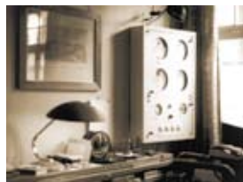
Schreibtisch und Schalttafel im Erdgeschoss des Kontorgebäudes, Büro des Herbert von Forster
