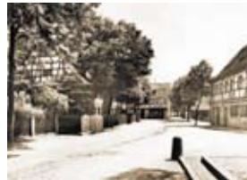
Wirtshaus Christoph-Carl-Platz von Westen, links Kontorgebäude, Mitte Gießerei, rechts Wirtshaus
