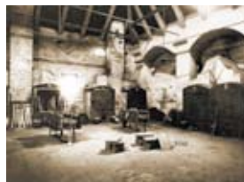
Innenansicht der Gießerei mit Schmelzöfen, Gussformen, Werkzeugen, Grafitriegeln, Messingplatten
