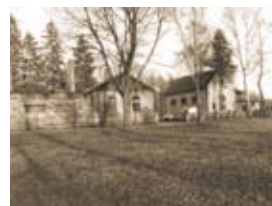
Gießerei und Gebäude des Elektrizitätswerkes, Ansicht von Südwesten
