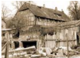
Uhrenhaus und Stützmauer (Südmauer des Walzwerkes) mit Resten der Kohleschütten vor der Restaurierung
