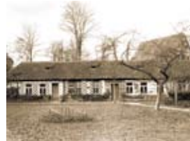
Gärtnerhaus und Nebenräume im Herrengartenhaus
