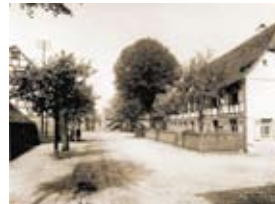
Christoph-Carl-Platz von Osten, rechts das Kontorgebäude, links Giebel des Wirtshaus, im Hintergrund Uhrenhaus
