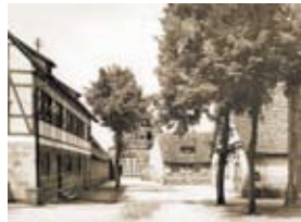
Bauernhaus, Westtor Ansicht der Gebäude Christoph-Carl-Platz 1, 2-4 und des Bauernhauses, des Westtores und der Scheune
