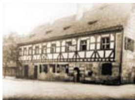
Wirtshaus „Einkehr zum Hammer“, Ansicht von Nordosten
